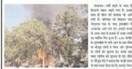
ट्रांसफॉर्मर में लगी आग, कई घरों की बत्ती हुई गुल।
